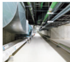
空調設備、配管などの工場インフラは地下に配置。
