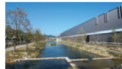
調整池。大雨時の排水調整に寄与し、工場の冠水を防ぎます。
