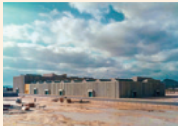
「島野山口株式会社」として完成した下関工場。
