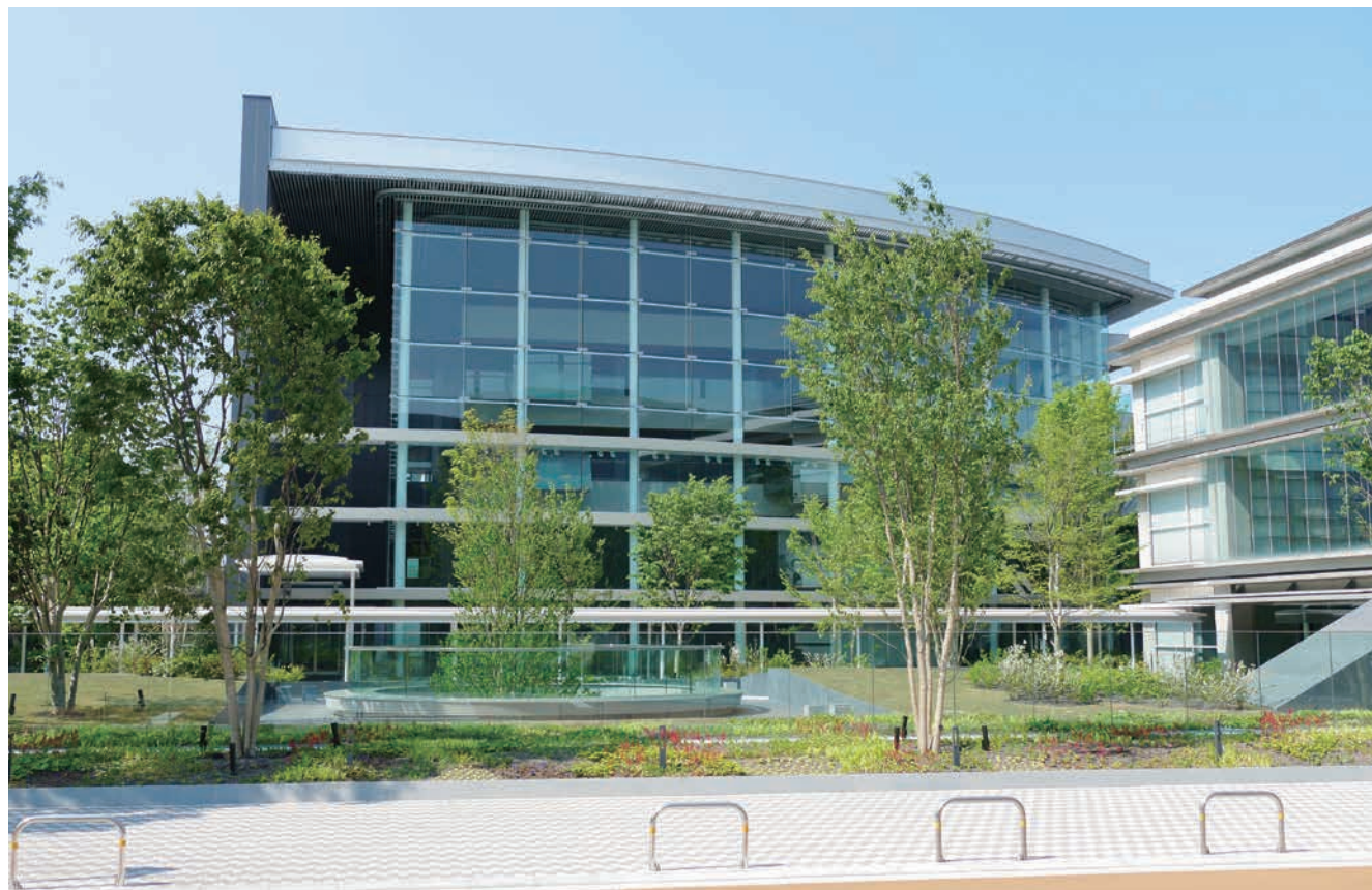
TICの外観(北側)
