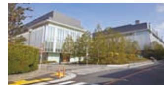
シマノ本社工場 (大阪府堺市) Sakai Intelligent Plant
