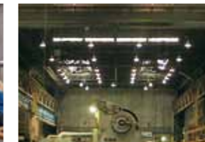
水銀灯を省エネタイプに変更することで、年間58tのCO 2 の削減に成功しました(シマノ下関工場)
