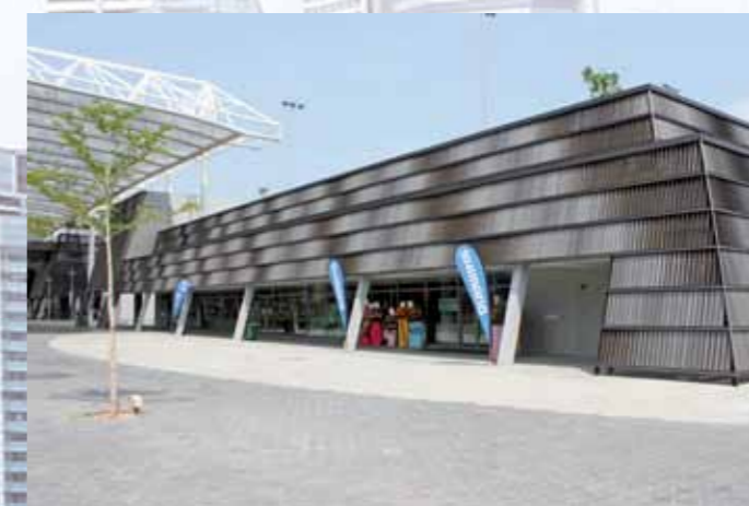
SCWのエントランス
