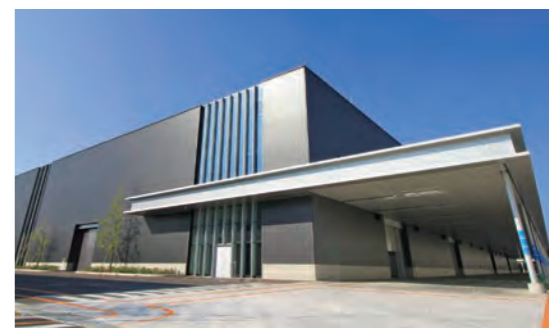
シマノ下関工場 新工場 (山口県下関市) Shimano Shimonoseki Factory Intelligent Plant
