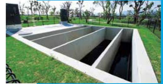
油水分离槽。为防止厂区流出的工厂废水以外的雨水等直接流入调节池，先将全部收集到油水分离槽内进行过滤。
