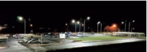
禧玛诺捷克公司将钠灯变为 LED 灯
