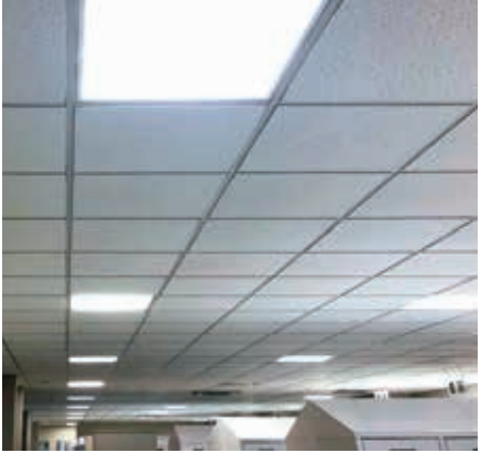
禧玛诺昆山公司 改善照明项目
