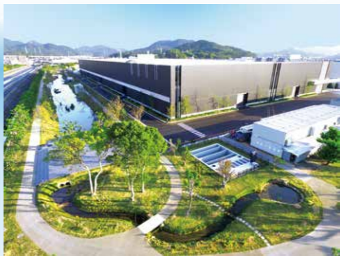
禧玛诺下关工厂调整池 “图片：Placemedia”
